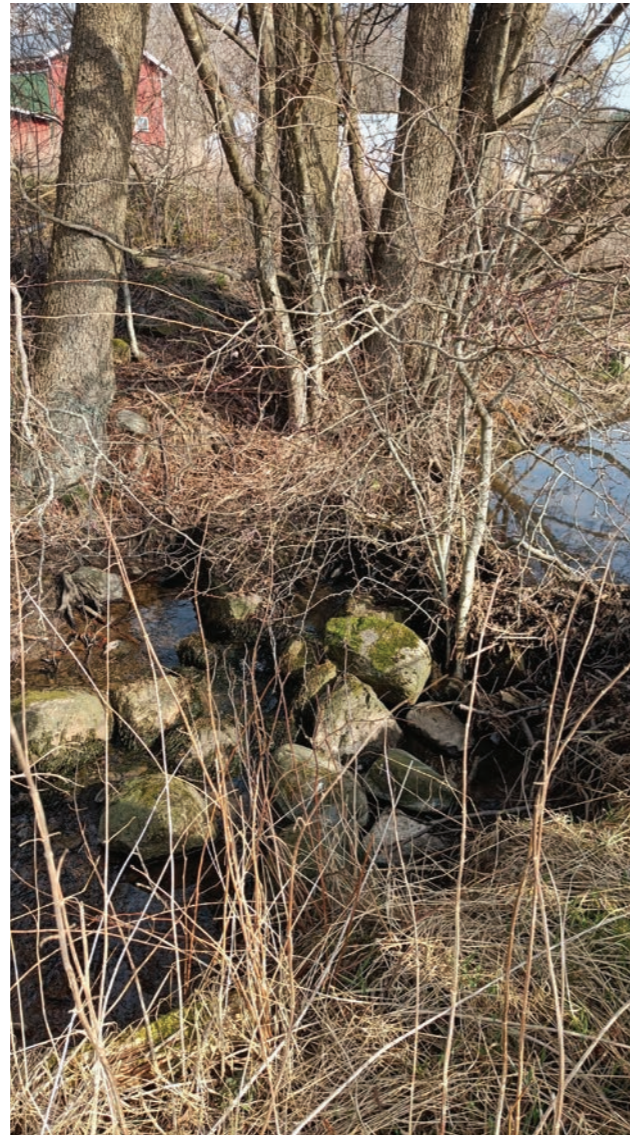
Fig 7. Det utrivna dämnet. Foto från sydväst.
